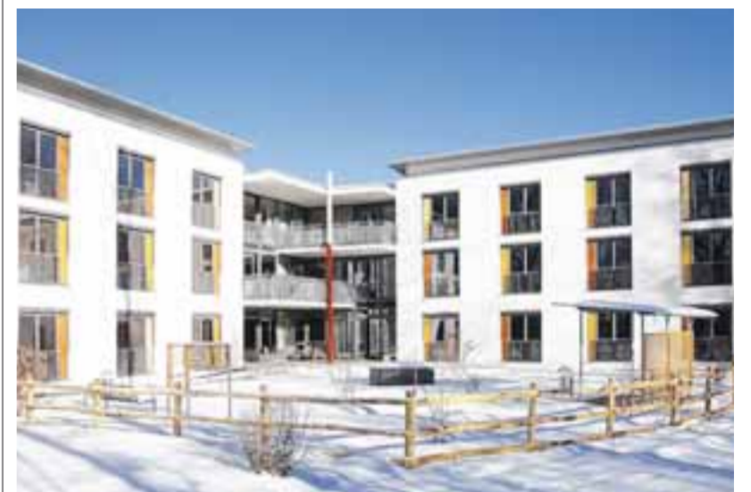
Der erste Bauabschnitt des AWO-Seniorenzentrums an der Lenzfrieder Straße, das Pflegeheim, ist fertig und kann am Sonntag besichtigt werden. Foto: Laurin Schmid
